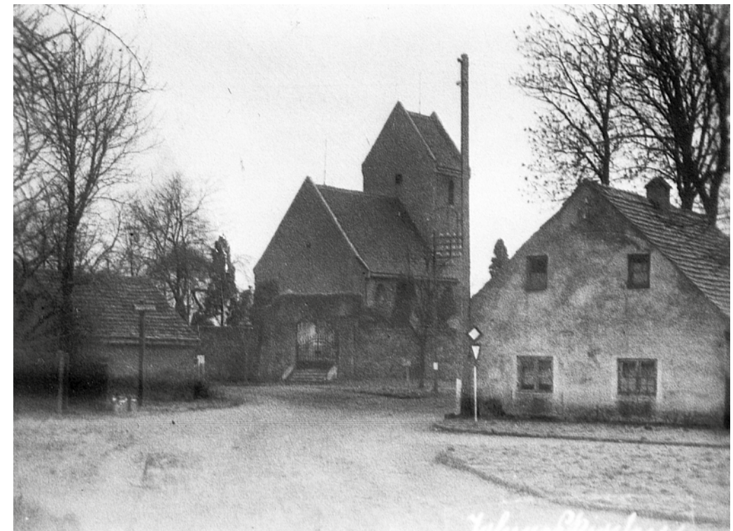
Das Gemeindehaus (Haus No. 9)
