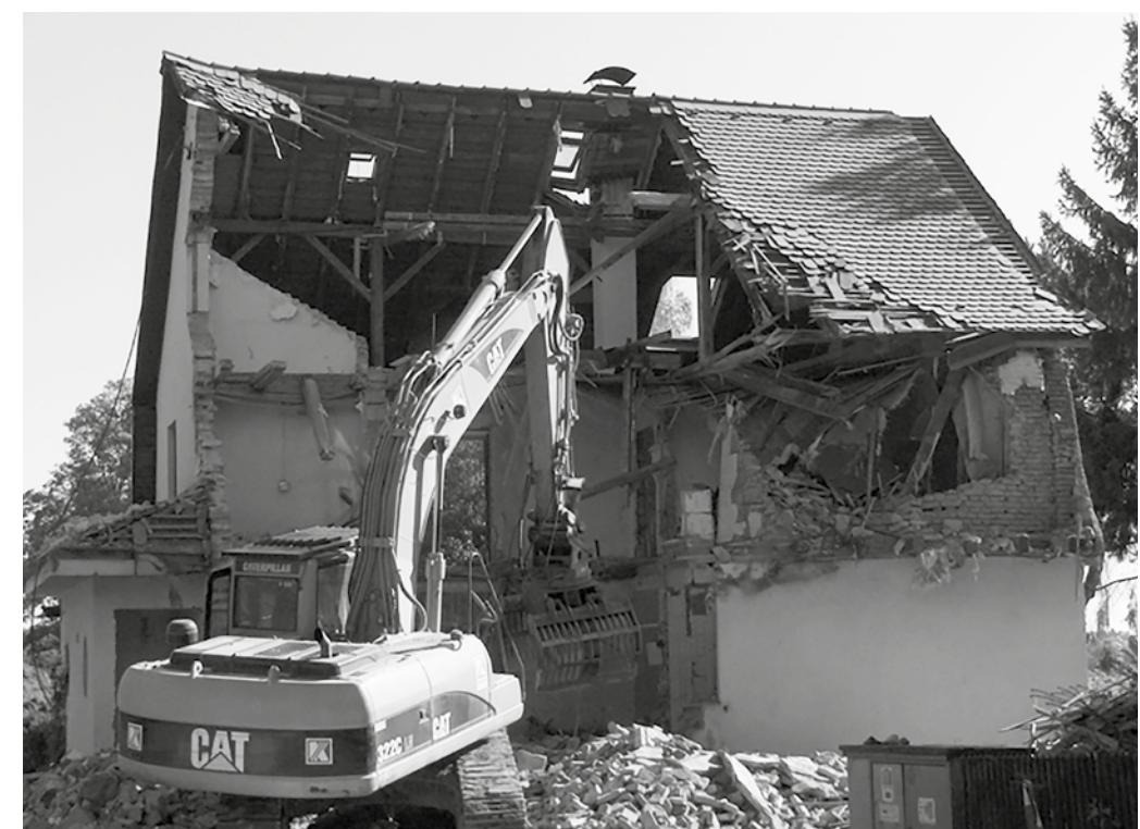
Haus No. 8 1/2, die »Wagner-Villa« an der Musenbergstraße wurde 2005 abgerissen
